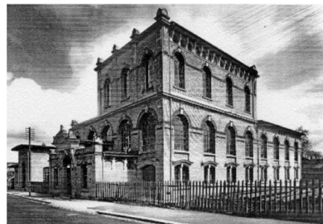
Abb. Historische Aufnahme des Transformatorengebäude / Quelle: unbekannt
